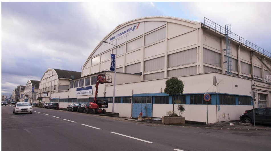
HANGARS LOSSIER ©Joëlle Mestas - IMAGERIE
